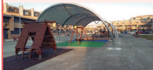
La empresa Maderplay está colocando una cubierta textil en el parque infantil de la plaza Cortes de Navarra. Estará apoyada y tensada sobre una estructura metálica galvanizada fijada mediante cimentación. La cobertura, de color blanco, es textil, ignífuga y con protección UV.
