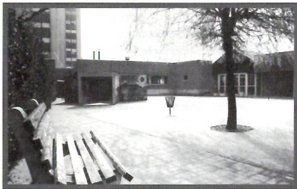
En esta zona del patio del centro escolar es donde se está construyendo la nueva ala.
