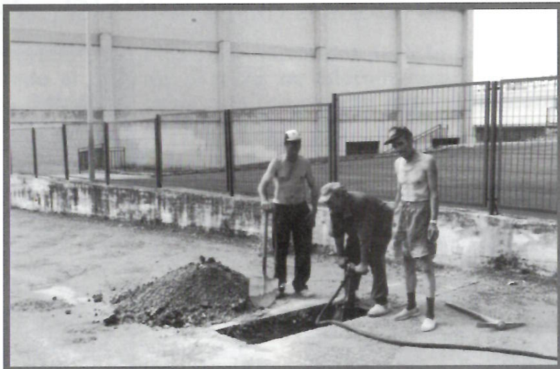
Los primeros trabajos se han realizado en la calle Fermín Tirapu.
