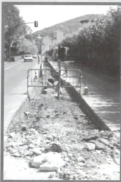
Aspecto de las obras en Serapio Huici.
