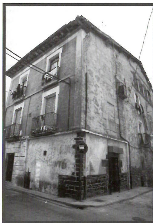
Estado actual del edificio número 42 de la calle Mayor.
