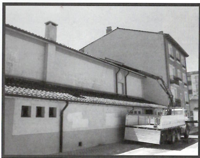
El Ayuntamiento está a expensas de recibir un informe técnico sobre el estado del inmueble.
