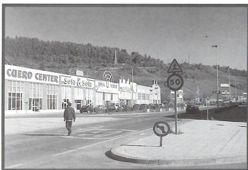
Las obras mejorarán el tráfico en esta importante vía de circulación de Villava.
